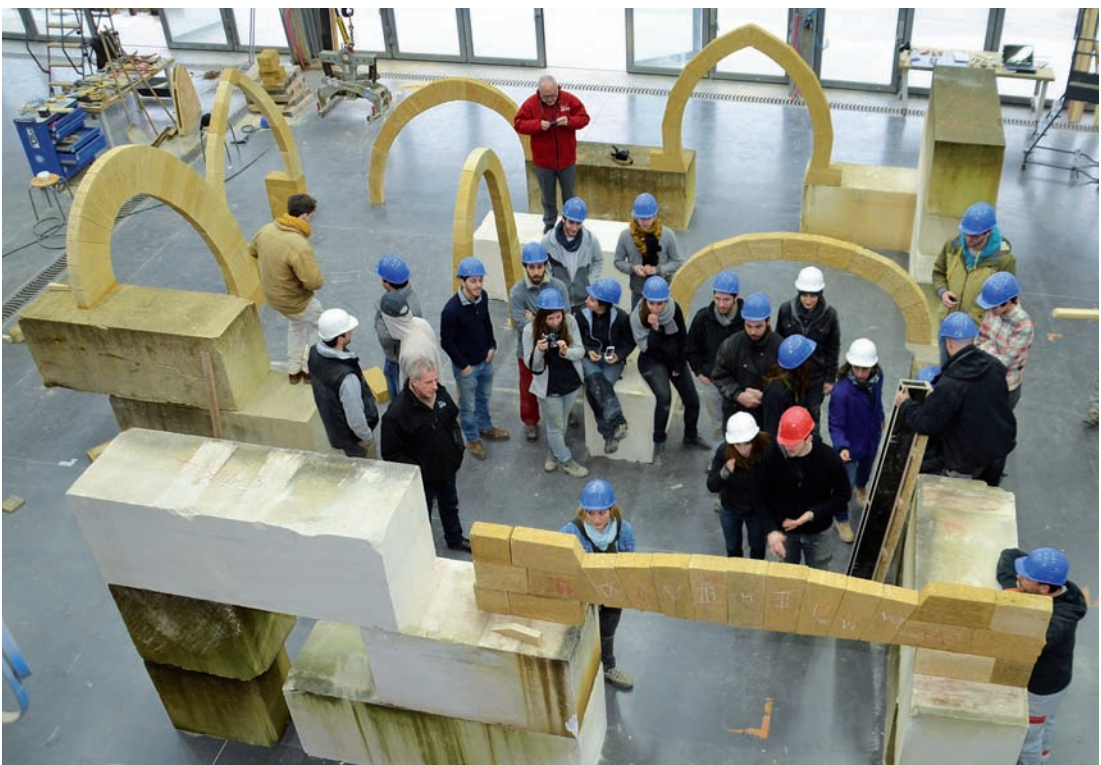
Les sept arcs décoffrés, réalisés par les élèves architectes de l'ENSA de Grenoble, aux Ateliers de l'Isle d'Abeau, sous la direction d'Elisabeth Polzella.
